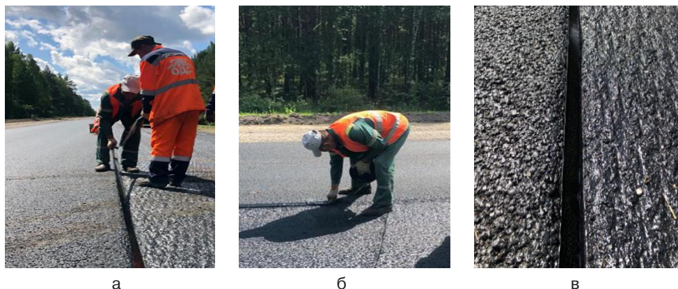
Рис. 4. Разматывание, укладка, прижатие ленты по поверхности шва и снятие антиадгезионного слоя (а, б), вид готового шва перед укладкой горячей асфальтобетонной или полимерасфальтобетонной смеси (в)
