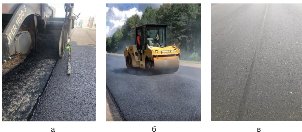
Рис. 5. Распределение горячей асфальтобетонной или полимерасфальтобетонной смеси (а), укатка сформированного слоя (б), вид готового шва в итоговом покрытии (в)
