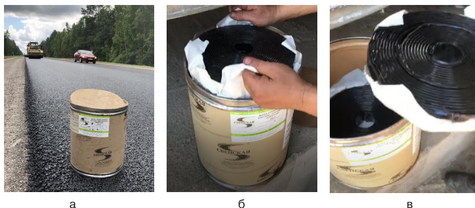
Рис. 2. Картонный барабан с металлическим обрамлением (а), извлечение ленты стыковочной битумно-полимерной из барабана (б), послойное размещение рулонов ленты в барабане (в)
