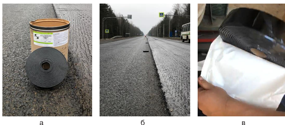
Рис. 3. Картонный барабан с информацией о ленте (а), раскладка рулонов ленты вдоль образуемого шва сопряжения (б), антиадгезионный прокладочный слой для предотвращения слипания рулонов ленты при транспортировке и хранении (в)
